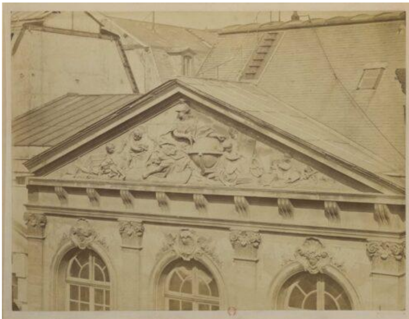
Louis-Émile Durandelle (1839-1917), Bibliothèque nationale : façade nord de la cour avant les travaux de reconstruction, Minerve promenant son compas sur le globe terrestre sur le fronton de l'aile Robert de Cotte, 1876, Bibliothèque nationale de France, département Estampes et photographie, EO-98 (1)-BOITE FOL A
