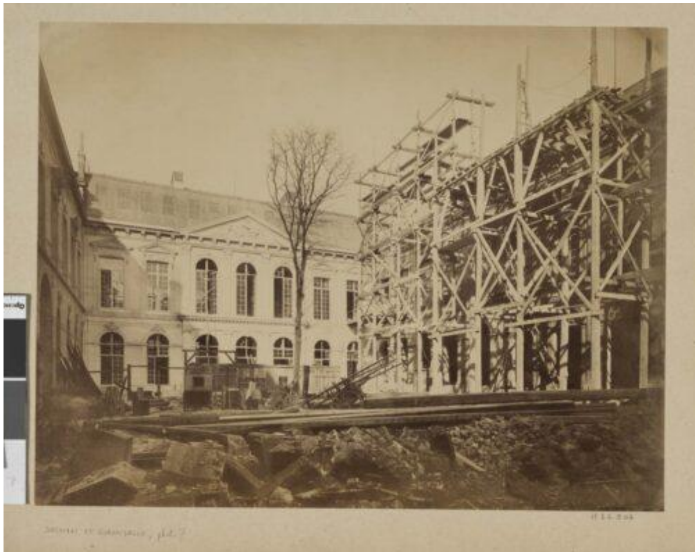
Louis-Émile Durandelle, Bibliothèque nationale, chantier du « bâtiment Robert de Cotte » par Jean-Louis Pascal, façade sur la cour d'honneur, 1882. Tirage positif sur papier albuminé, 36 × 45 cm, BnF, département des Estampes et de la Photographie, VA-237 (2) folio 33 .
